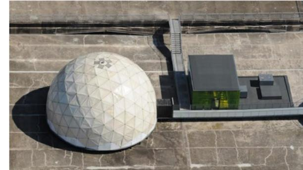
Le Radôme et sa plateforme sont liés à l'intérieur de la base par un percement et une tour d'escaliers.
